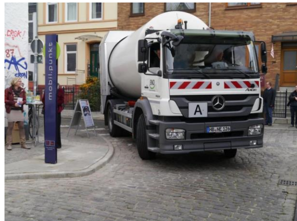
Beitrag zur Rettungssicherheit: Gehwegnasen an Einmündungen verhindern behinderndes Parken in den Einmündungen
